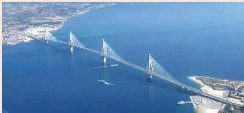
由南钢供钢、中国企业按欧盟标准建造的克罗地亚佩列沙茨跨海大桥
