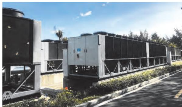
■ 安裝空氣源熱泵，減少天然氣耗量，生產熱水的同時為空調機房、走道和花房降溫
