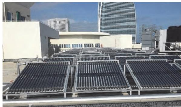
■ 太陽能熱水管道改建，通過改建將太陽能制熱能力發揮最大，取消燃氣熱水器制熱
